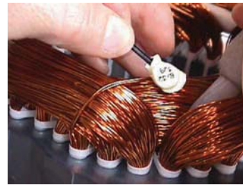
Figura 5.5 - Instalação do termostato na cabeça da bobina
