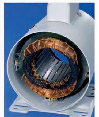
SOBREAQUECIMENTO NO ENROLAMENTO AUXILIAR
