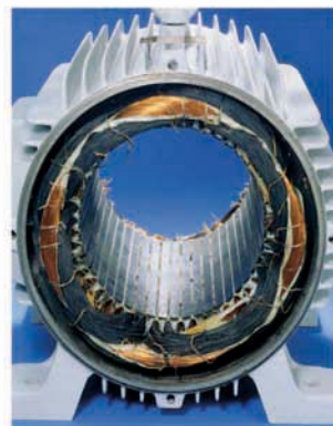
FALTA DE FASE LIGAÇÃO ESTRELA
